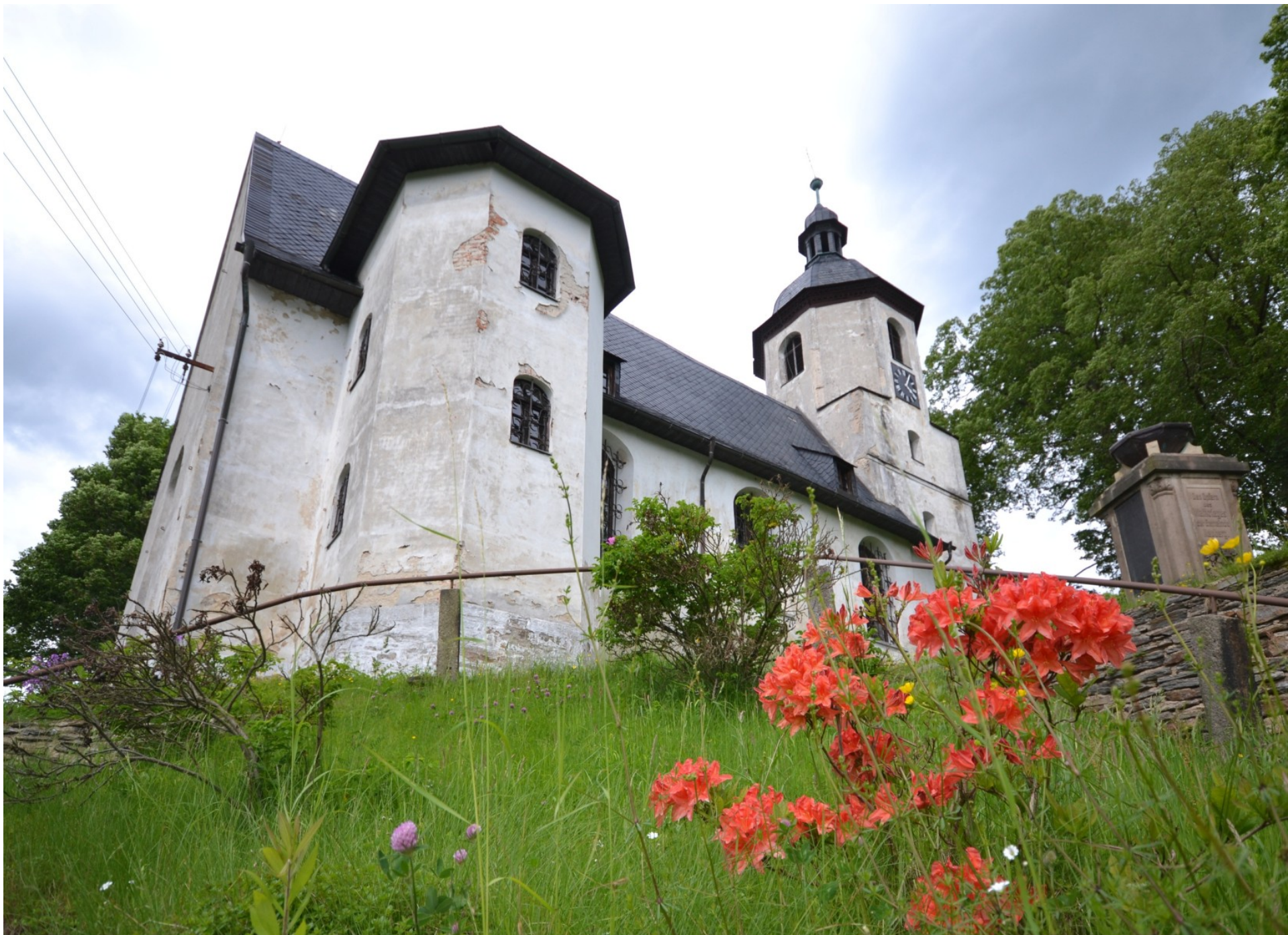
Evangelický kostel Dobrého Pastýře v Podhradí. Přestavba z r.1682.
